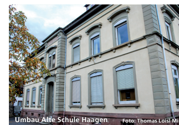
Umbau Alte Schule Haagen Foto: Thomas Loisl Mink
